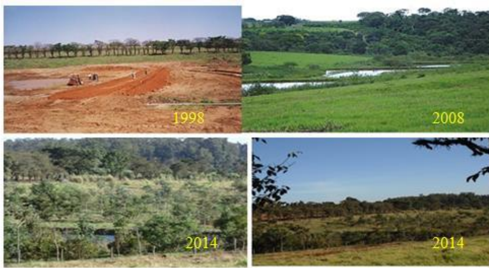
Figura. 2: Construção dos açudes para estabilização de voçoroca em 1998, após a finalização da obra em 2008 e após a implantação do Sistema Agroflorestal em 2014
